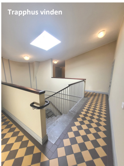
Förlängning av trappa upp till vind
